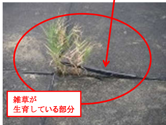
写真1 押さえコンクリートの目地に雑草が生育
